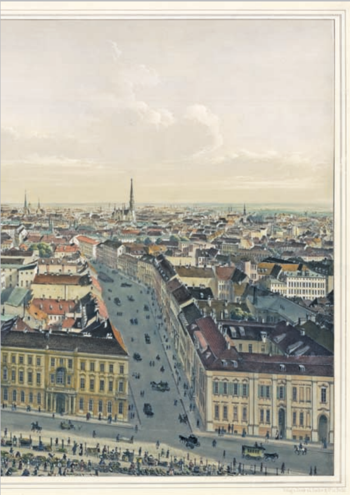
vorne: Markgrafenstraße mit Lotterie-Direktion Ecke Jägerstraße, gegenüber Preußische Seehandlung (Eckhaus)
